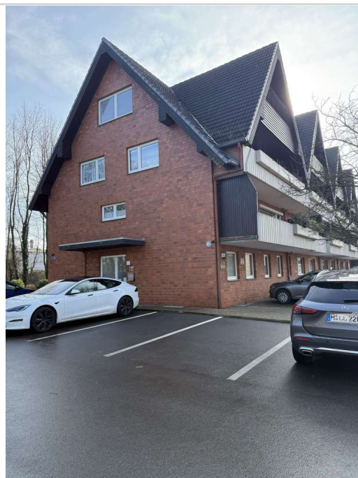
Eingang mit Parkplätzen
